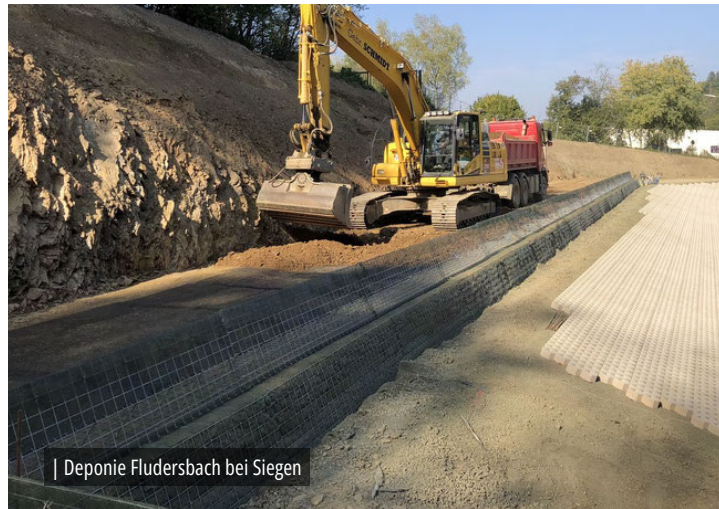
| Böschungssicherung L561 Schalksmühle-Heedfeld
