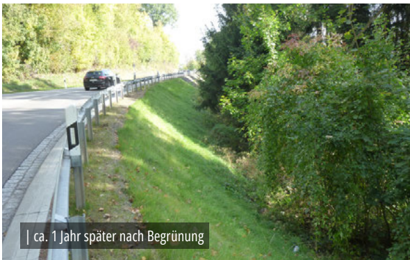
| Fertige Steilböschung kurz nach Bauende
